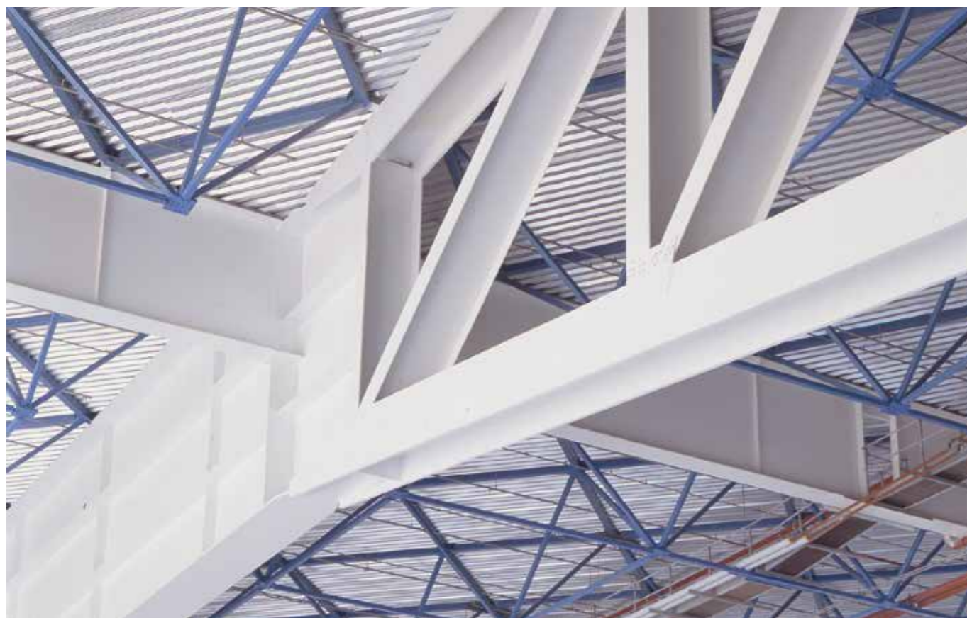
Patalpose esančios plieninės konstrukcijos dengtos viršutinio sluoksnio dažais „Temacoat GPL“
