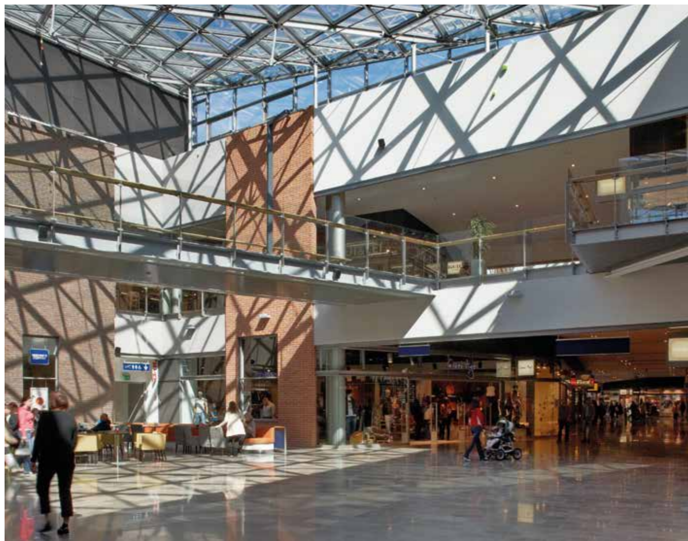
Patalpose esančios plieninės konstrukcijos dengtos gruntu „Temaprime EUR“ ir viršutinio sluoksnio dažais „Temalac FD 50“
