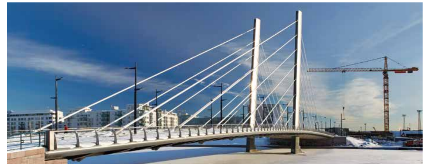
Tiltų konstrukcijos dengtos gruntu „Temazinc 77“ ir dažais „Temacoat GPL-S MIO“ bei „Temathane 50“
