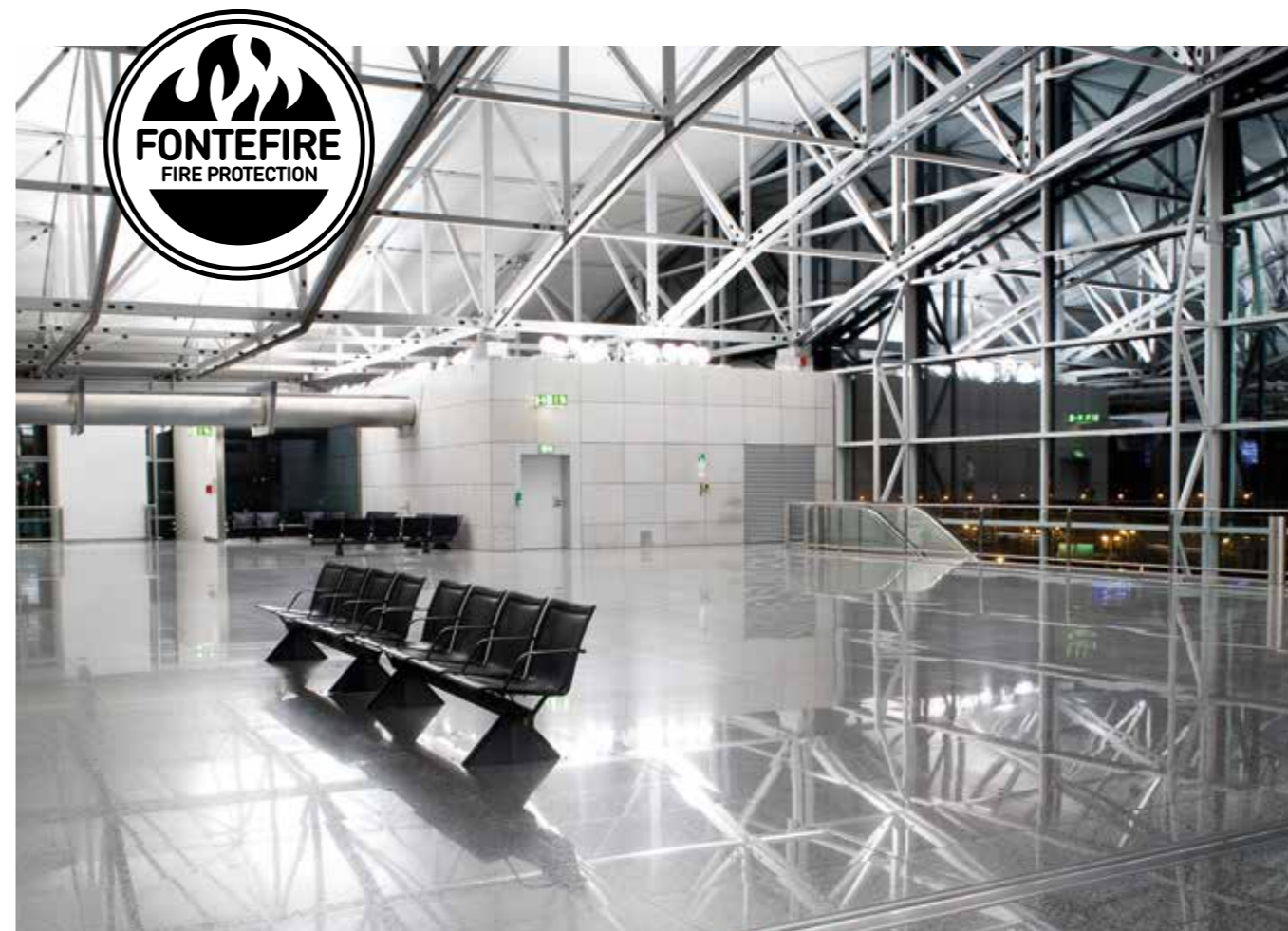
Plieninės konstrukcijos dengtos gruntu „Temacoat GPL-S Primer“, priešgaisrine danga „Fontefire ST 60“ ir dažais „Temadur 50“
