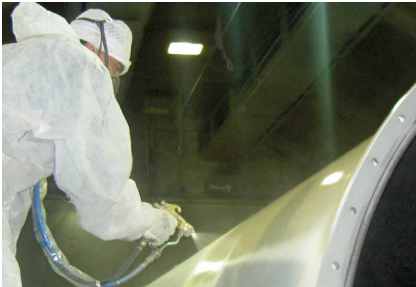
Transformatorius dengtas gruntu „Temazinc 77“, „Fontecoat EP 50 Beige“ ir dažais „Fontedur HB 80“
